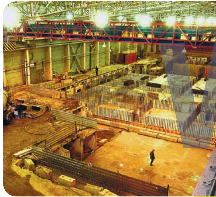
Future W-ECP construction site
