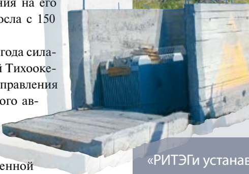
РИТЭГ внутри бетонного защитного короба
