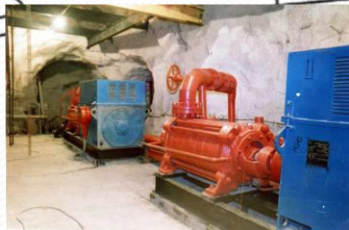
Насосная ПВ с растворосборником
