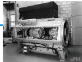
КРУЭ (с элегазовой изоляцией)
