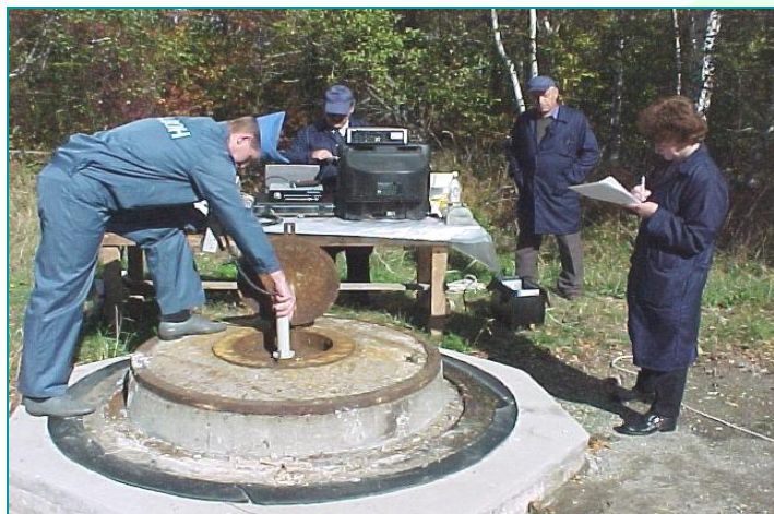
Кондиционирование отработавших ИИИ на «ЭКОРЕС» (Беларусь, 2003)
