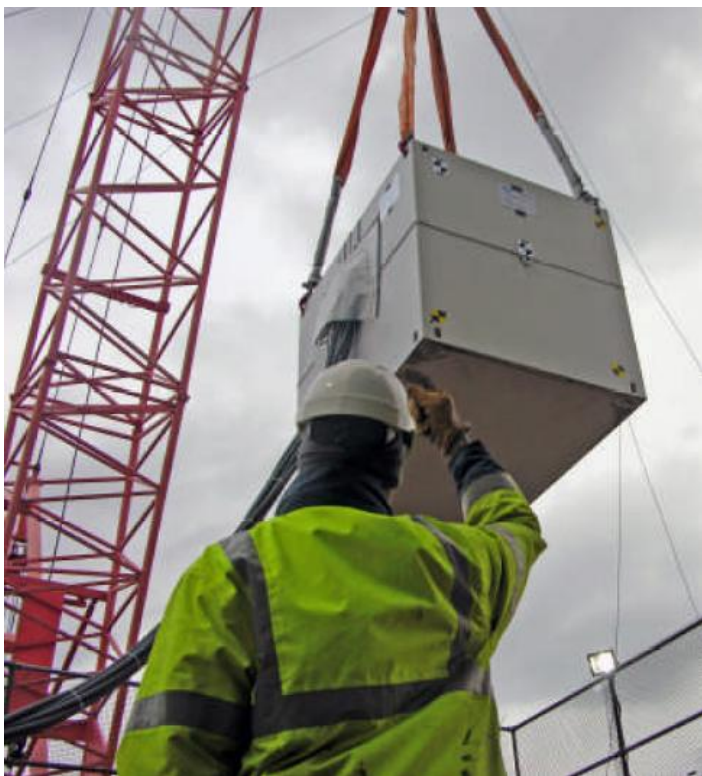
Броское испытания BlueBox® с 5.2 м
